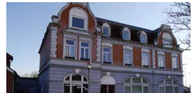
Schöne Fassade erhalten - Innenstadtgestaltung vorantreiben
